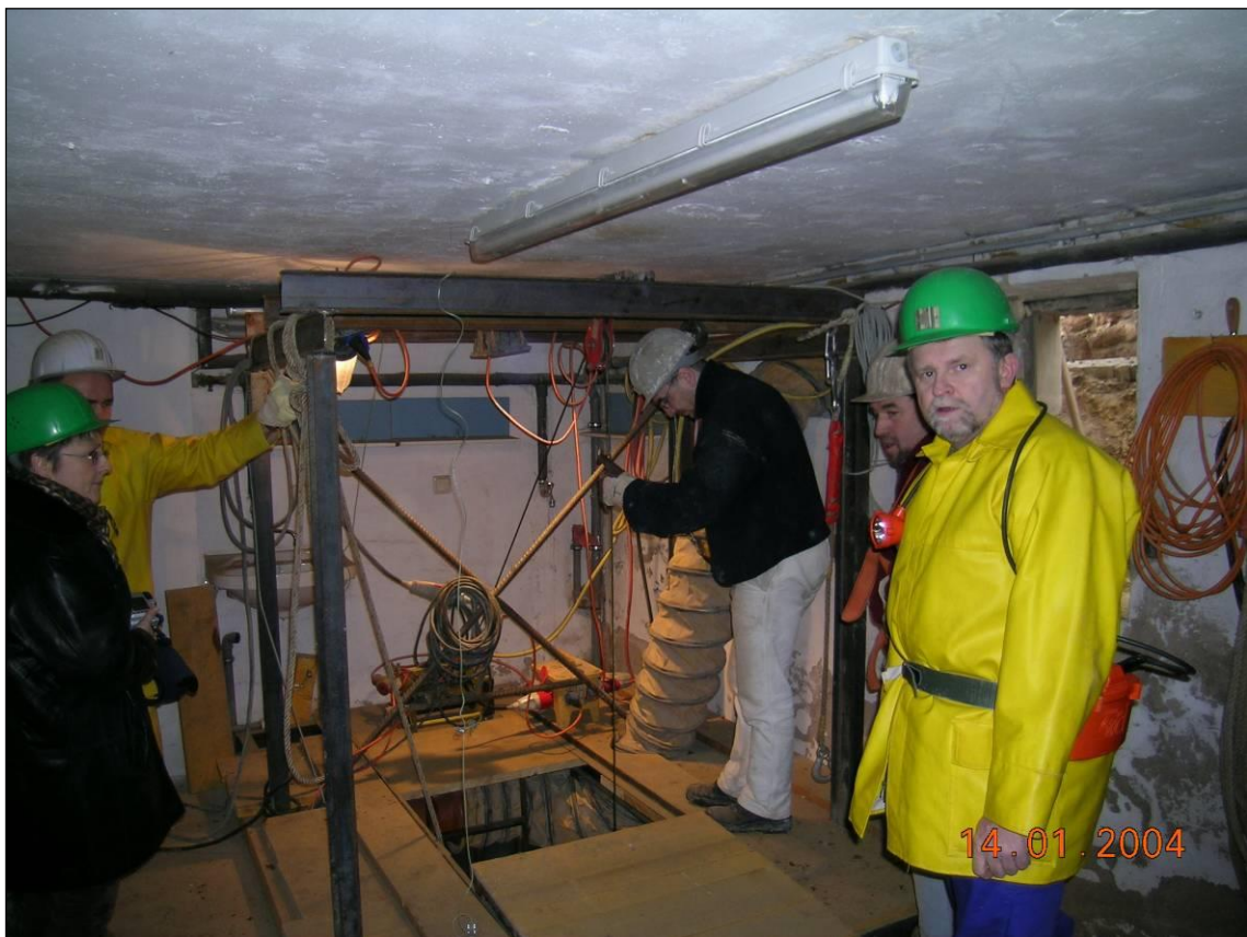
Abb.3 : Beengte Teufarbeiten im Keller zur Aufwältigung des 8. Lichtloches
