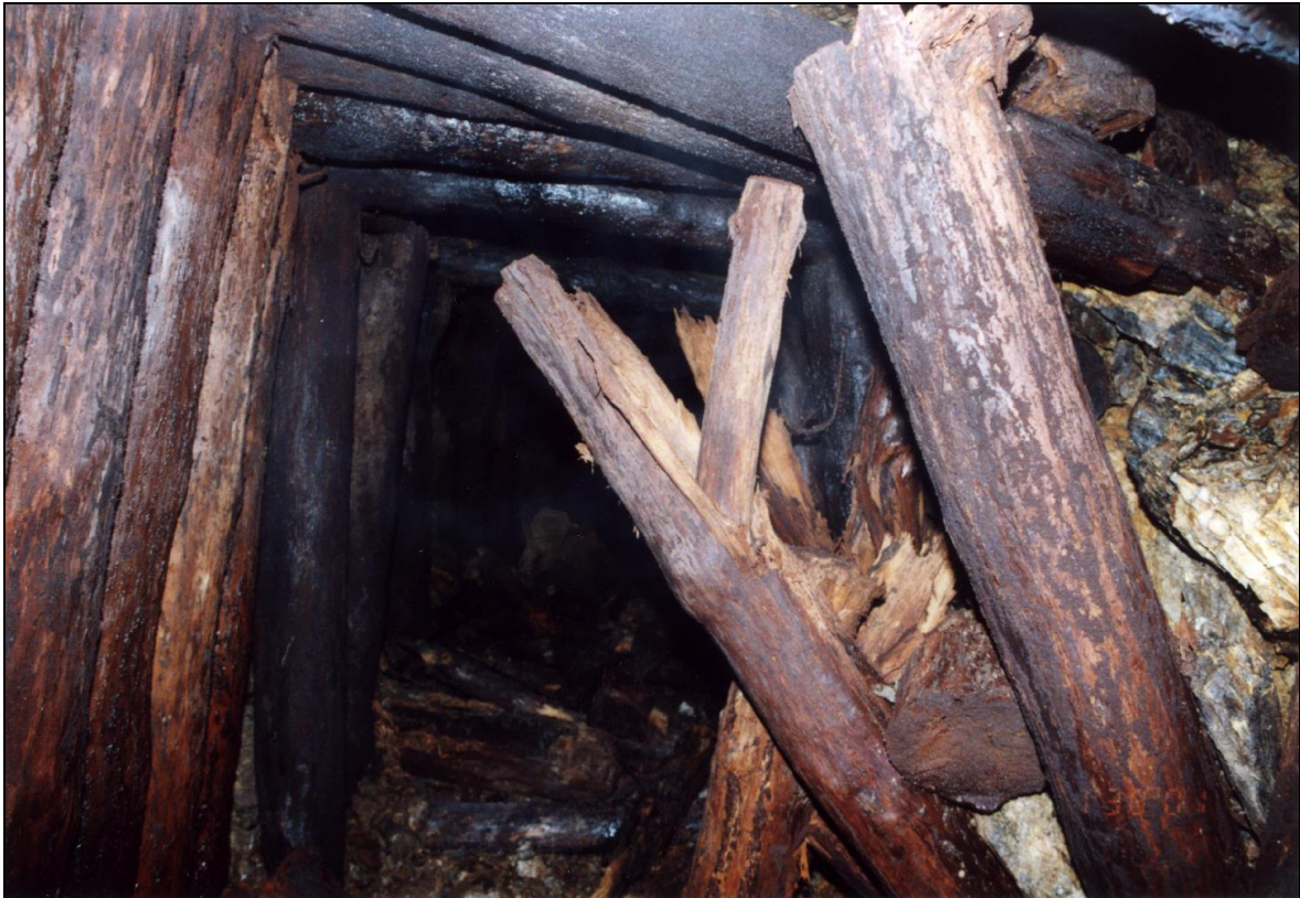
Bild 2: Holzausbau in einer Strecke des Altwismutbergbaus (Alter ca. 50 Jahre)
