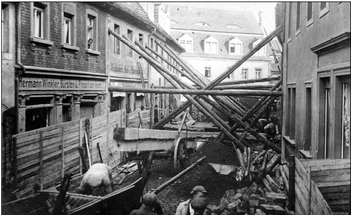
Bild 2: Durch Verbrüche von Bergkellern waren Abstützungen der Fassade an der inneren Meißner Straße notwendig (historische Aufnahme von 1926)
