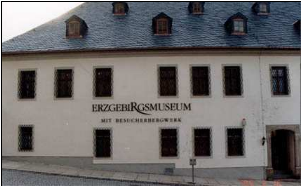
Bild 1: Ansicht des Erzgebirgsmuseums gegenüber der St. Annenkirche. Im Hinterhof befindet sich der Einstiegsschacht zum Besucherbergwerk
