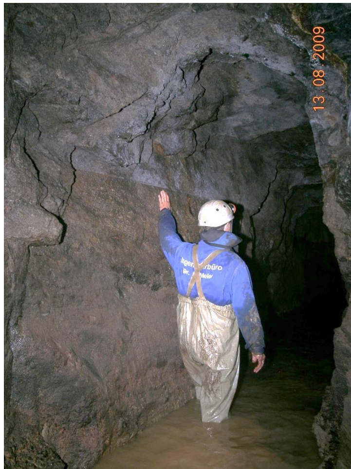
Abb.1: Wasserstandsmarke im Neuen Hirtenstollen
