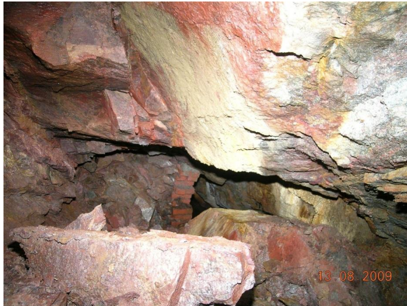
Abb.6: Grobstückiger Teilverbruch auf einer Störung im Neuen Hirtenstollen. In der Bildmitte ist das Ziegelgewölbe des Stollens zu erkennen.
