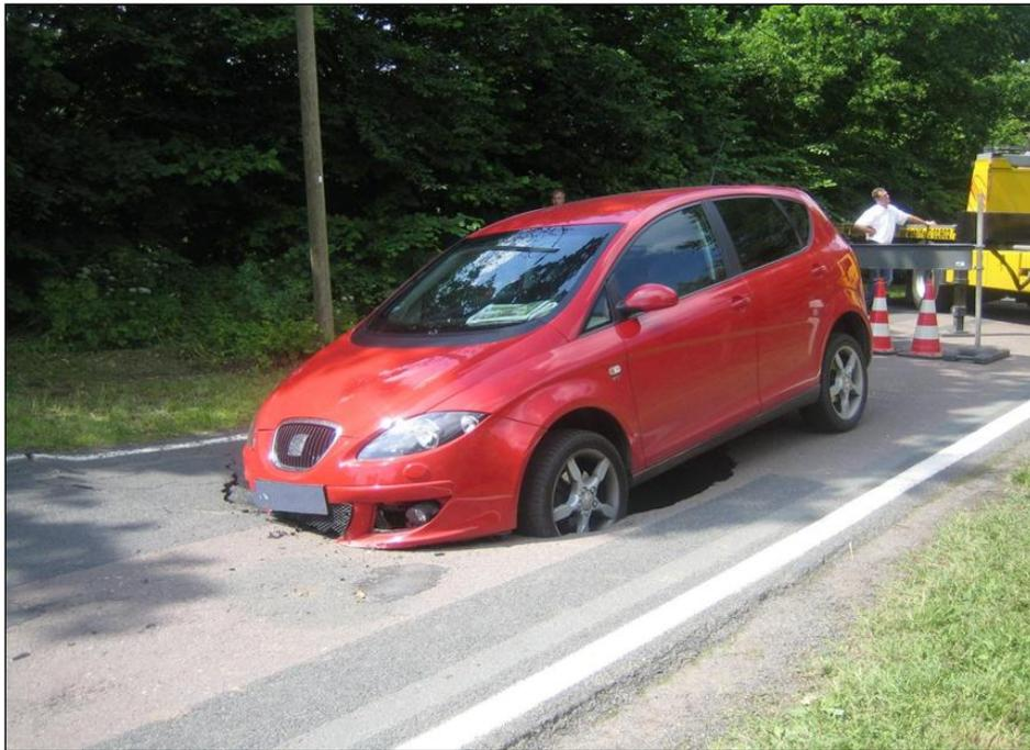
Abb.1 : Das Auto verstärkte fahrbahnmittig in einen Schachtverbruch des Kupferschieferbergbaues (Foto: Aberle)
