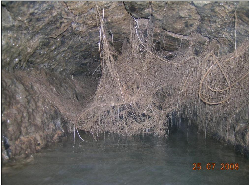
Abb.4 : Durch Pappelwurzeln vollständig verschlossener Stollenquerschnitt (luftseitig)
