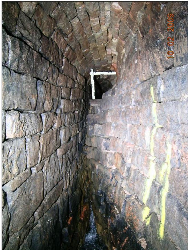
Abb.3 : Stollenverschluss durch Deformation des Natursteinausbaues
