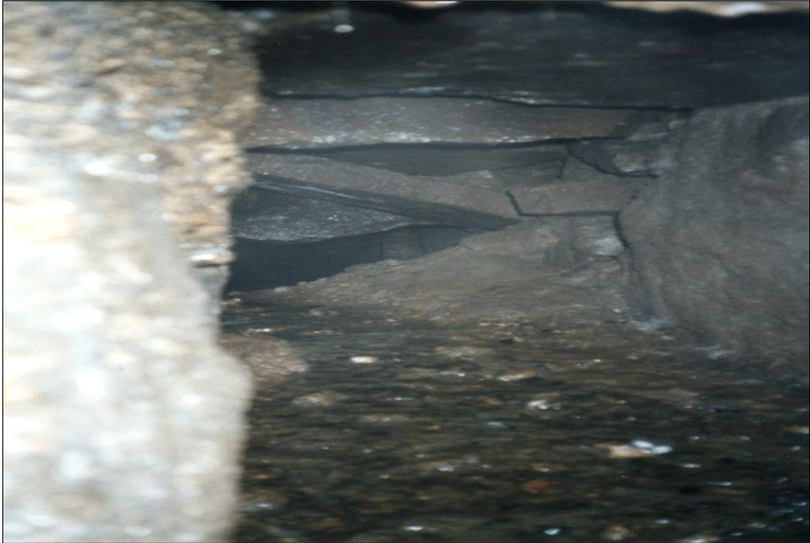
Abb.5 : Durchgebrochene Abdeckplatten einer Anzucht
