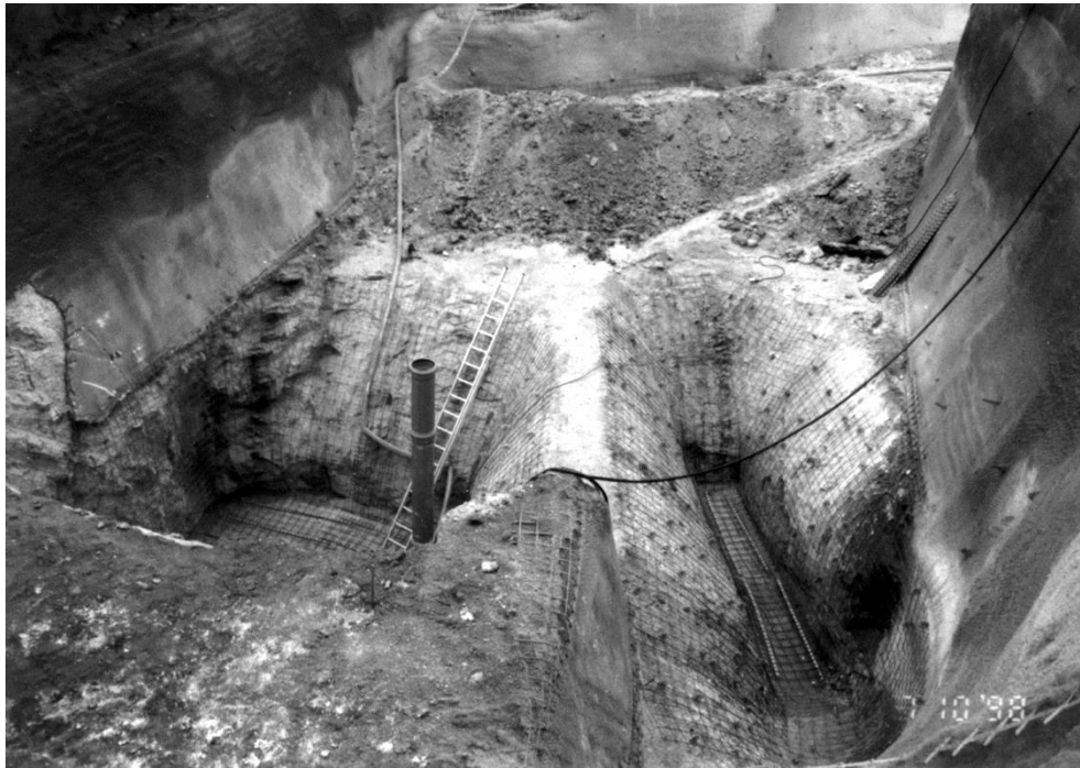
Abb.5 : Freigelegte Altbergbaurelikte vor der Betonage der Betonriegel
