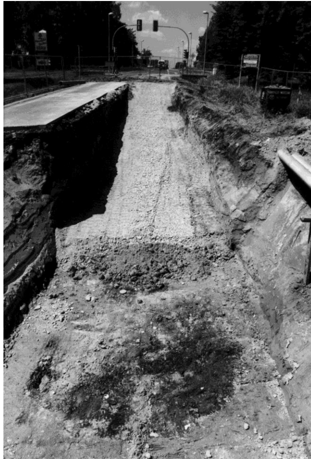
Abb.1 : Baugrubeneinschnitt im Straßenkörper bis zum Schacht (dunkler, runder Bereich)
