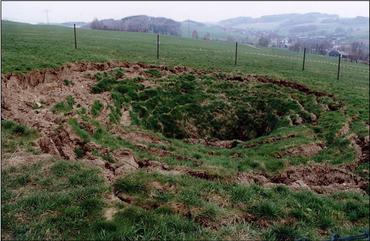
Bild 4: Verbruchtrichter eines Schachtes im Erzgebirge
