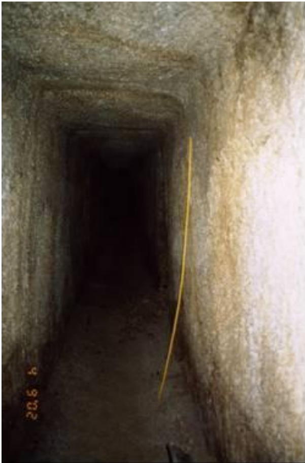
Abbildung 5: Rechteckiges Streckenprofil auf der 12-m-Sohle (Alter Stollen)
