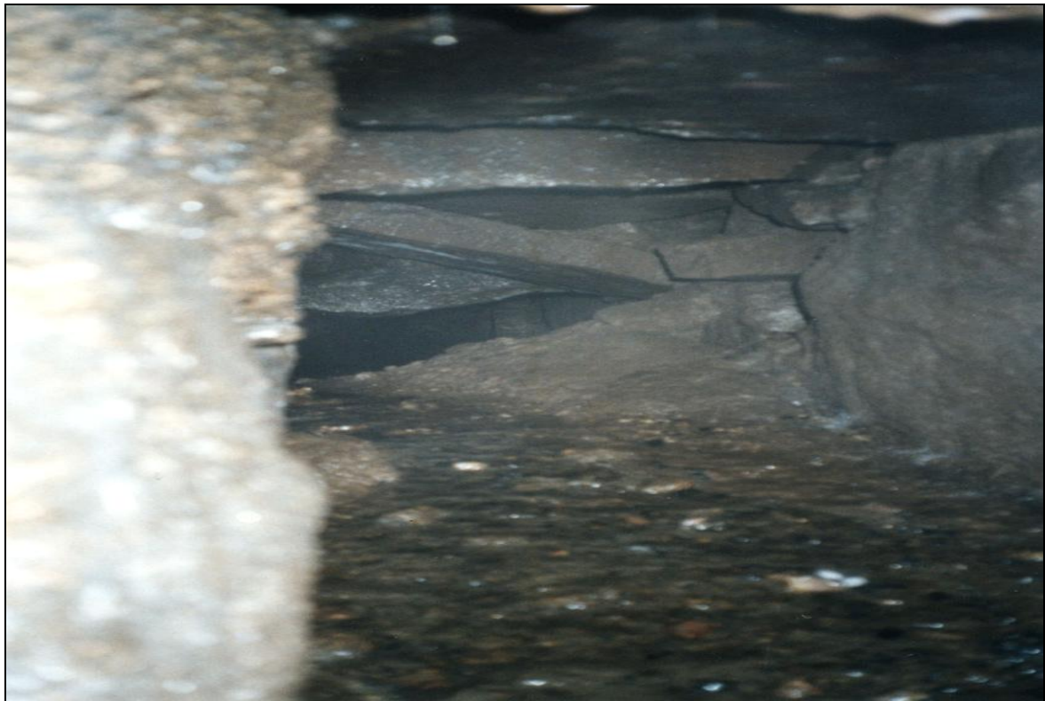
Bild 5: Durchgebrochene Abdeckplatten einer Anzucht
