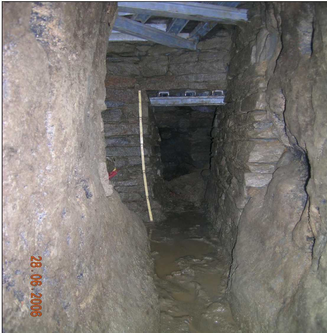
Bild 6: Gesicherte Firste durch verzinkte Stahlträger (Anzucht Burgstraße)
