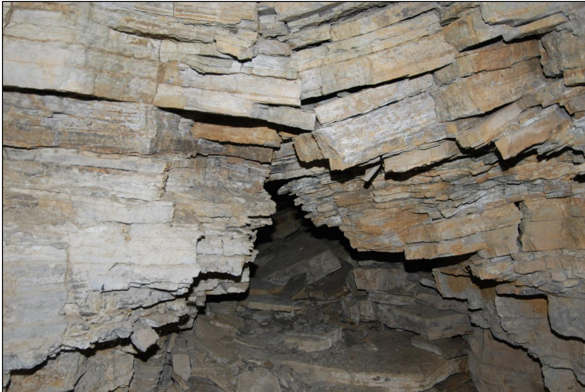
Bild 1: Verbruch der entfestigten Deckgebirgsschichten über den Grubenbauen
