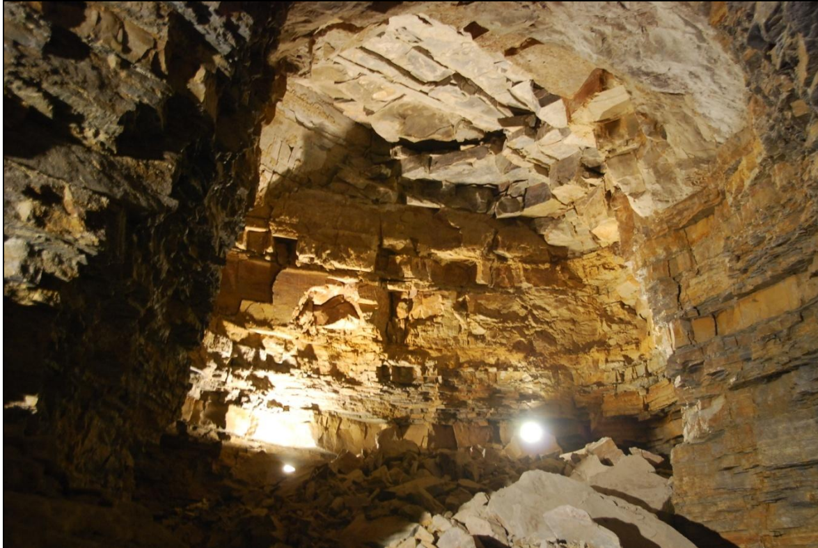
Bild 4: Aktiver, domartiger Hochbruch in einer großen Abbaukammer
