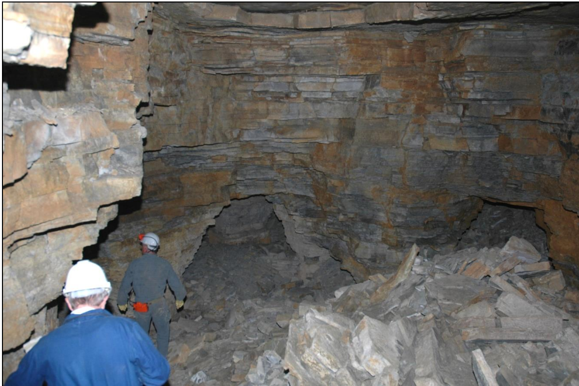
Bild 2: Große teilverbrochene Abbaukammer bei der Erstbefahrung
