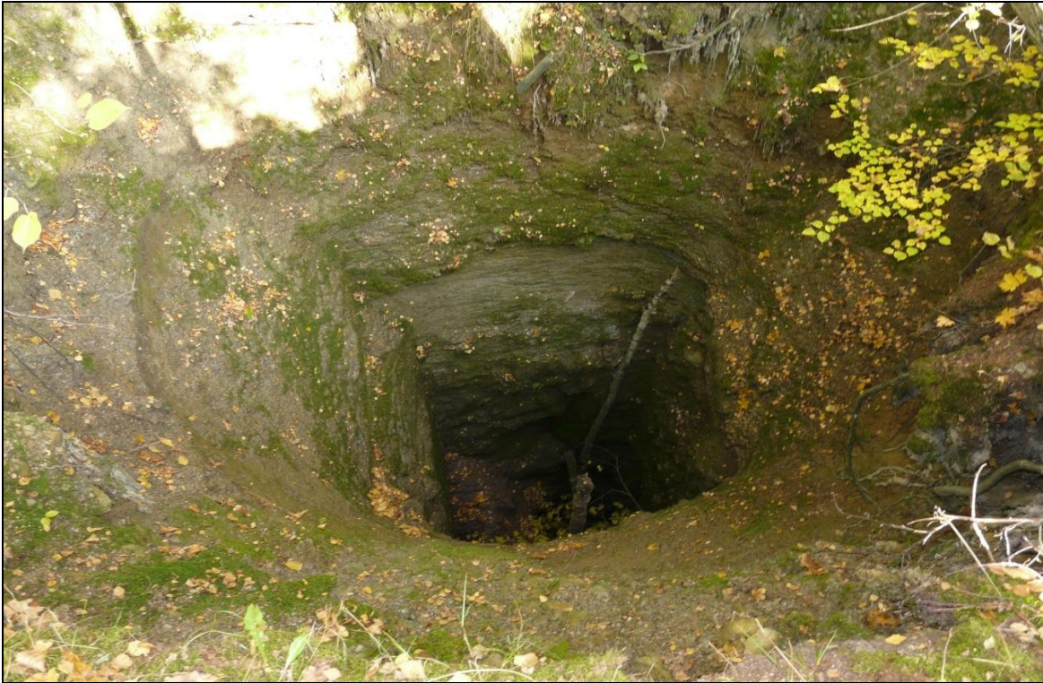
Bild 4: Der Schurf 23 (Abbaufeld Schacht 137) ist bis in 17 m Tiefe leerstehend.
