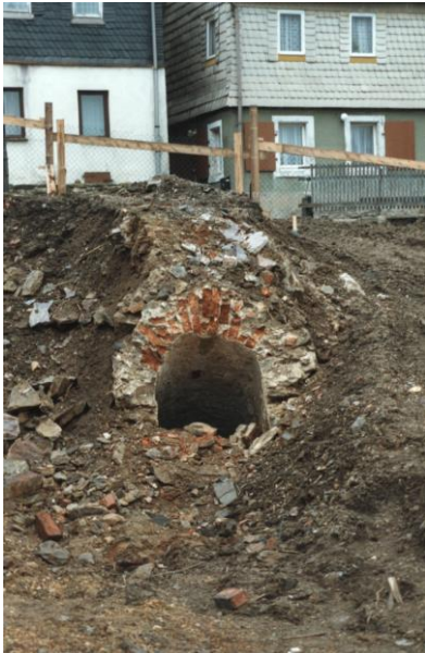
Bild 4: Freigelegter Kellerhals nach einem Gebäudeabriss in der Bergstadt Schneeberg.
