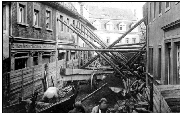
Bild 8: Eine defekte Wasserleitung führte zum Verbruch von Kellergängen und zur Deformation der Häuserfassaden der inneren Meißner Gasse in Lommatzsch (historische Aufnahme von 1926)
