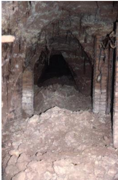
Bild 3: Verbrechender Tiefkellergang mit intensiven Wurzelbildungen unter einer Wohnbebauung in Crimmitschau.
