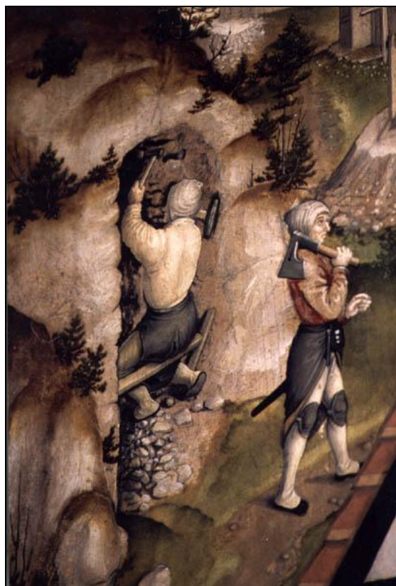
Bild 7: Schlegel- und Eisenarbeit in einem Stollen
